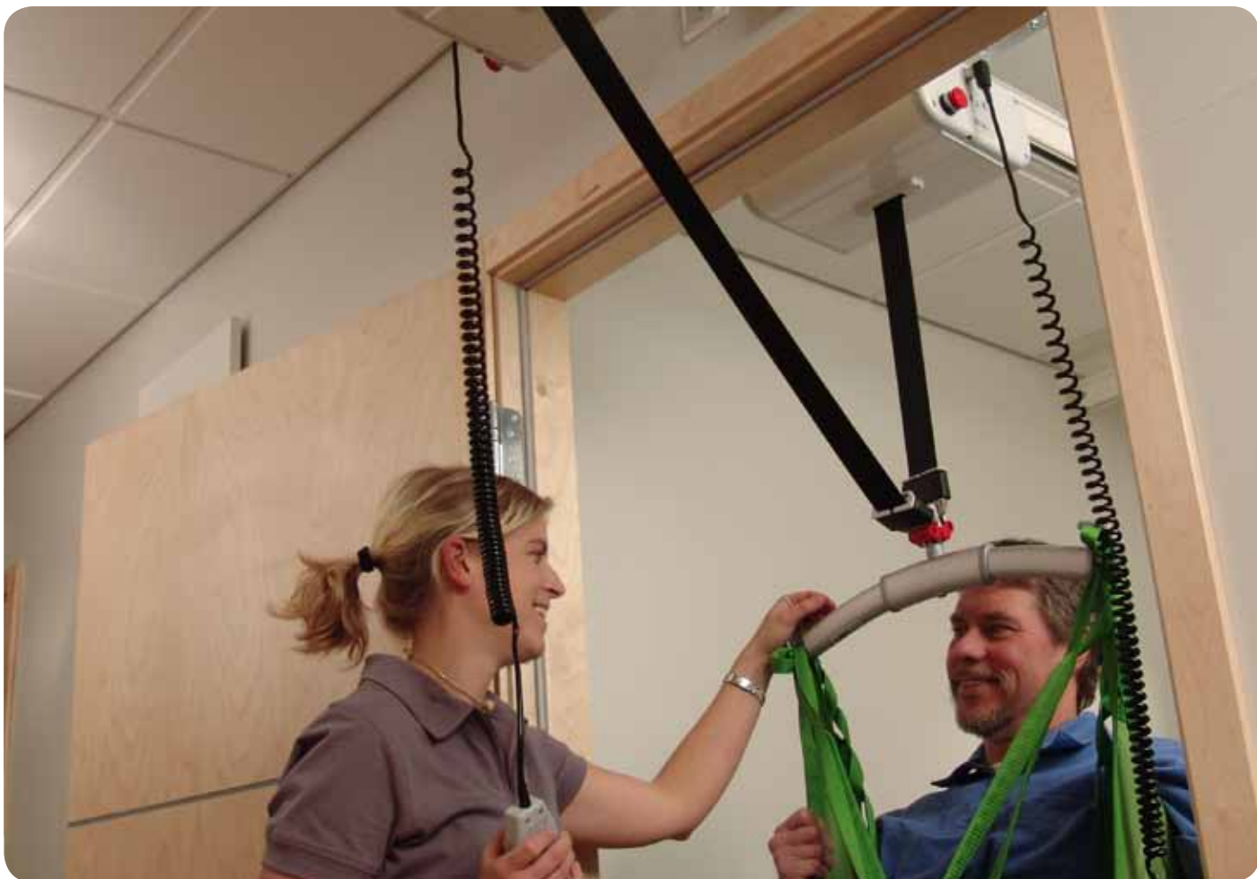
Met de Likorall R2R kan de patiënt worden verplaatst tussen twee kamers die geen directe railverbinding hebben.
